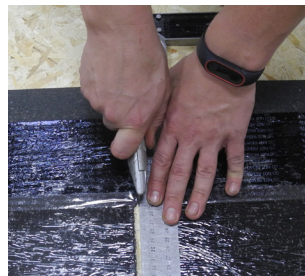
Рис. 77. Деление плитки на лепестки
