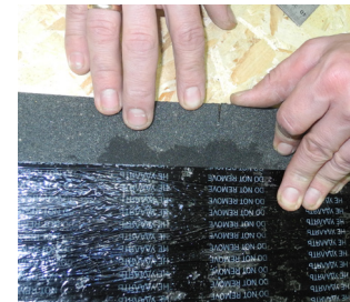
Рис. 76. Насечка для облегчения монтажа
